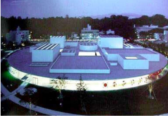
Mặt tiền xung quanh công trình là các miếng kính lớn
